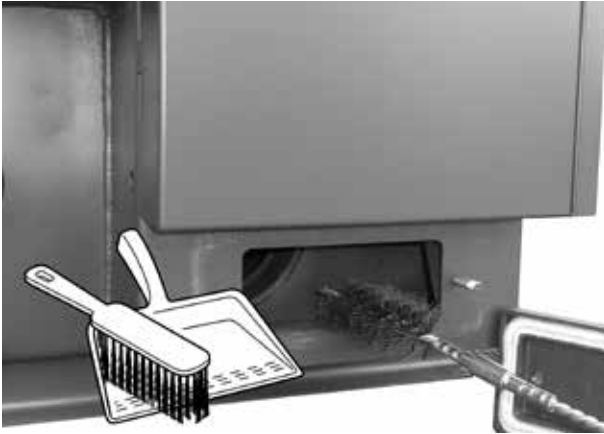
Usuwanie popiołu z dolnej części kanału spalinowego poprzez - wieczko dolne
