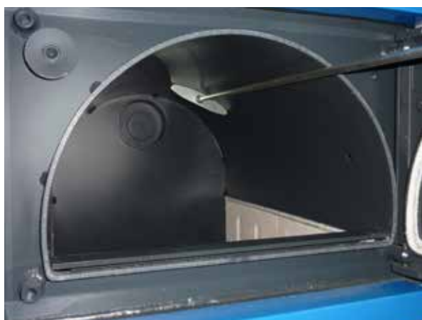
Czyszczenie górnej komory ładowania pogrzebaczem
