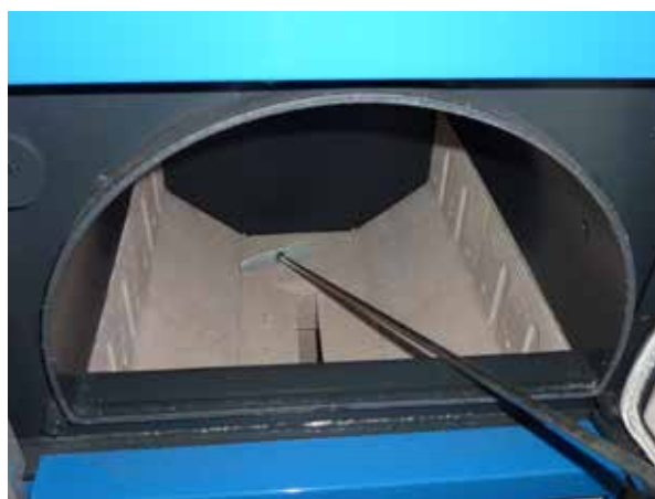
Zmiecenie popiołu przez dyszę do dolnej komory popielnika (spalania). Otwór w dyszy musi być zawsze czysty i drożny.
